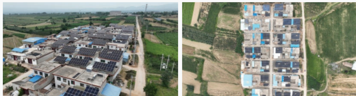
陕西铜川耀州区克坊村光伏项目
