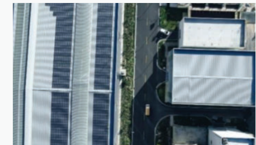
山西太原太钢集团BIPV屋顶
