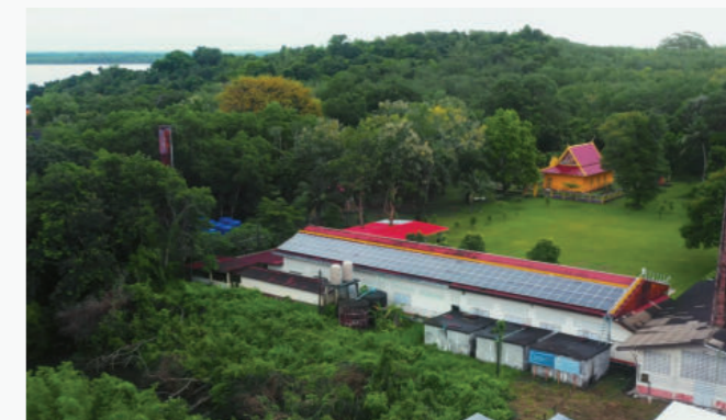
泰国Koh Jik居民屋顶安装隆基Hi-MO系列光伏组件
