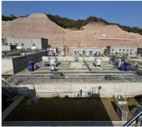
正在建设的禄丰市第二污水处理厂
