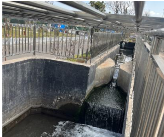
厂区现有生产废水排放口之一
