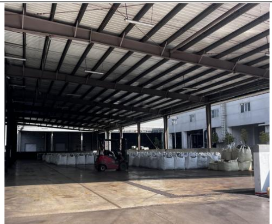
硅粉暂存棚现状照片
