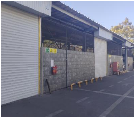
厂区现有的一般固废仓库
