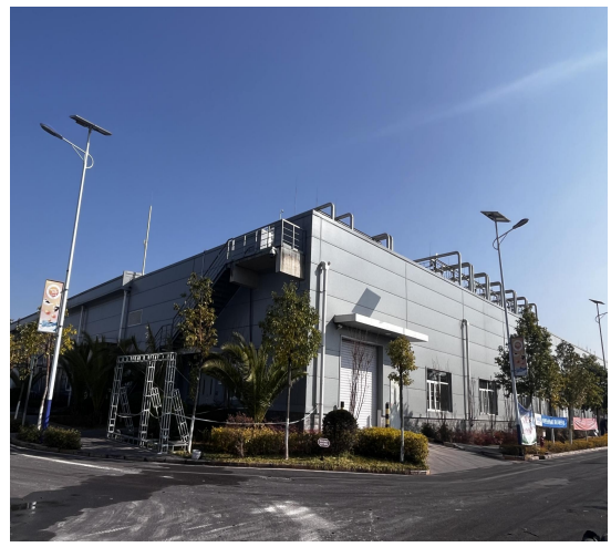
本次技改车间局部照片
