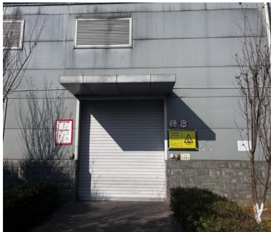
厂区禄丰隆基的危废暂存间
