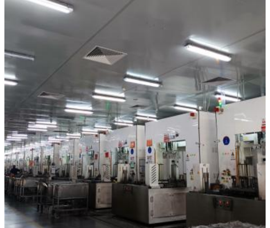
车间内清洗区现状照片
