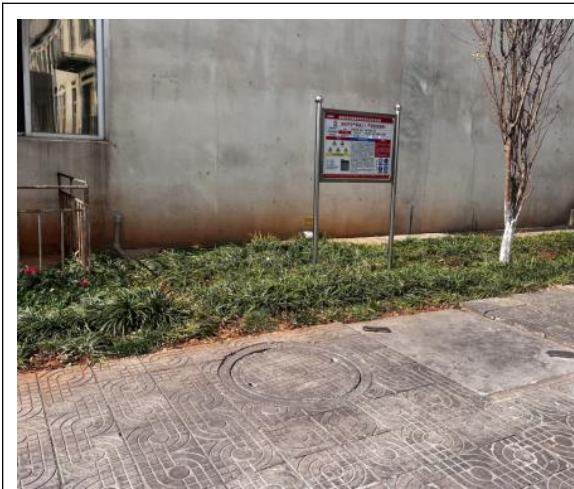
食堂边现有化粪池
